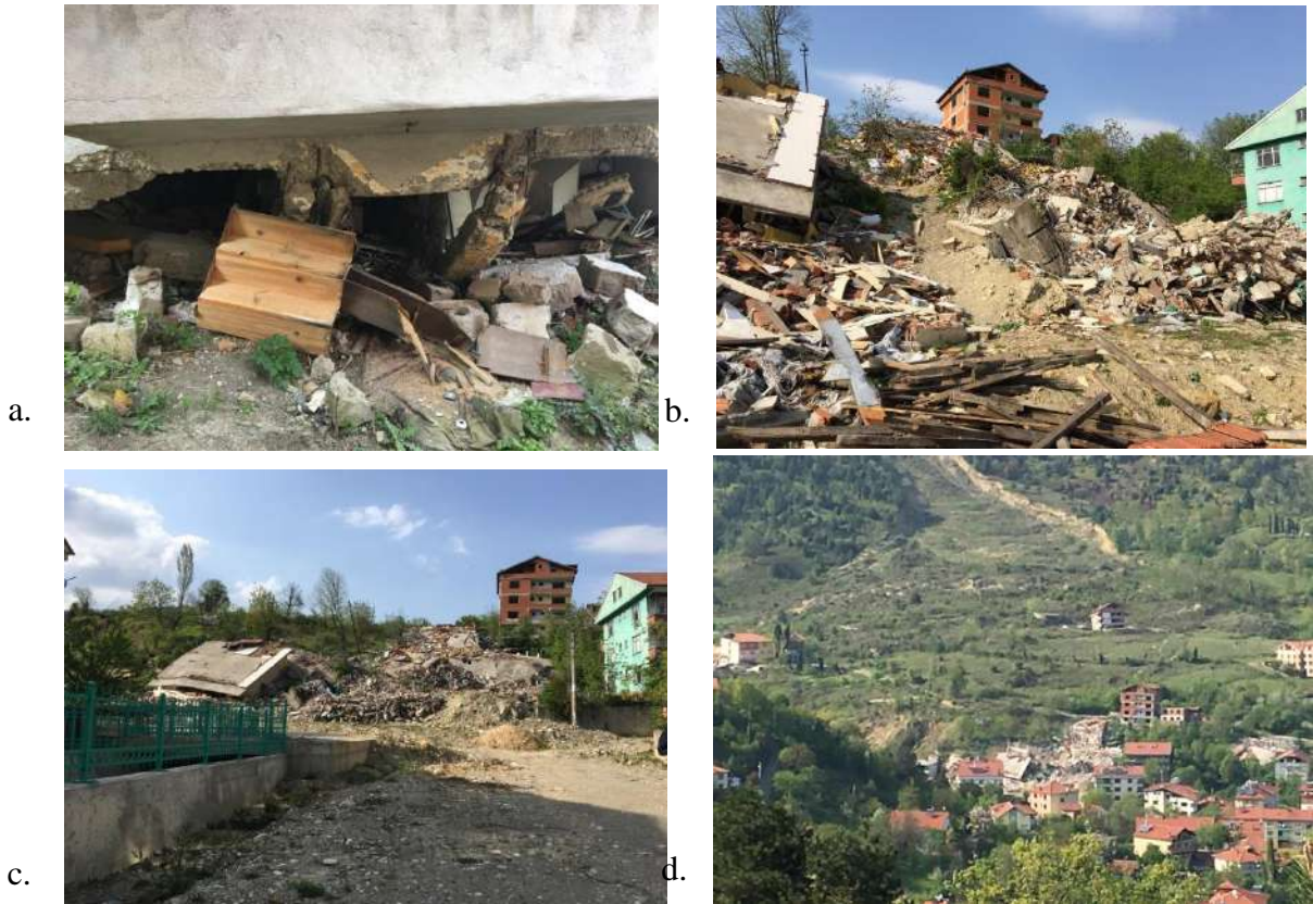
Şekil 4. Heyelanın hasar verdiği yapılar- Karşıyaka mahallesi
