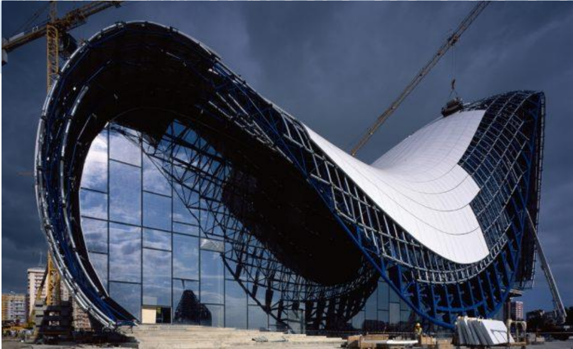
Resim 21: Haydar Aliyev Kültür Merkezi Yapım Aşamaları.
