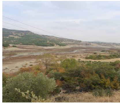
Sır Barajı (Kahramanmaraş)
